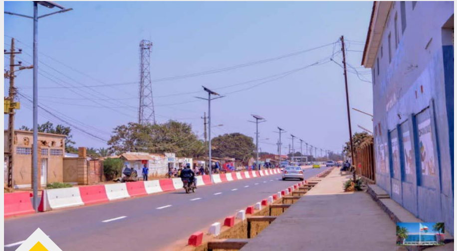
L'Ex Chaussée de Kasenga après les travaux de reconstruction.
